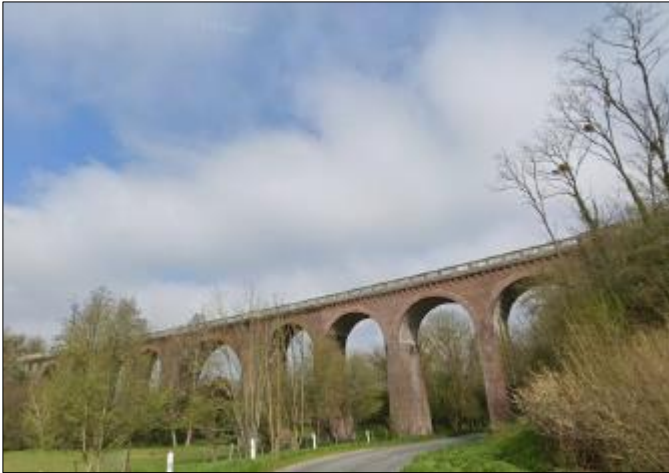
Viaduc présent sur le secteur 1
